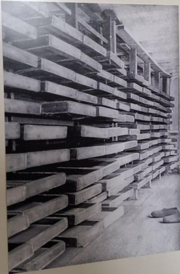
Am Hang oberhalb des Obergrabens zum Neuenhammer stand das Trockenhaus mit dem separaten Ofenbänken. Die Innenabnahme (unten links) macht deutlich, dass die Pulverarbeiter Holzschuhe trugen, um Fankerbildung zu vermeiden. Die beiden Pulverbunker am Untergraben (unten rechts) sind gut erhalten.
