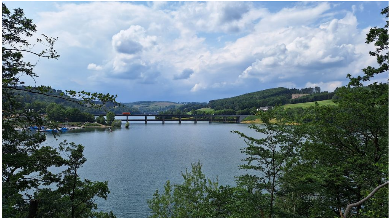
— Doppelstockbrücke Bigge: oben Autos, unten Bahn
