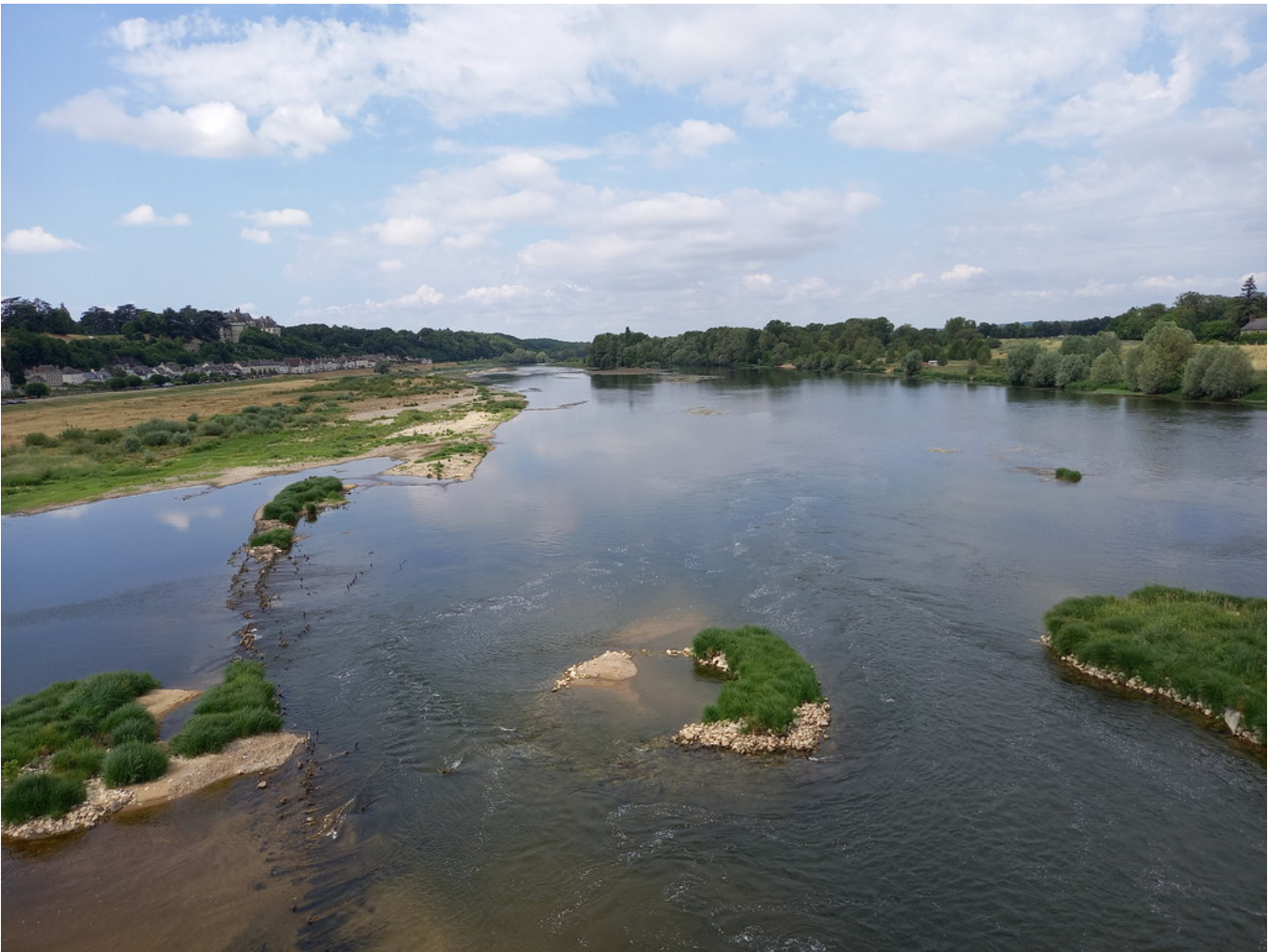
Diese kleinen Inseln im Wasser - das waren mal die Podeste der alten Brücke
