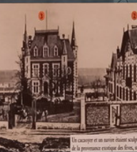
Un casierier et un autre atelier sculptés sur les façades. Seul le volume, repère de la prominence orientale des toits, subsiste sur le deuxième étage.
