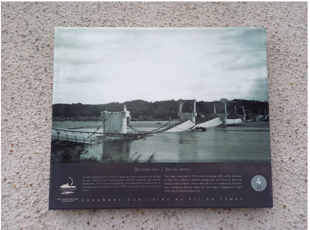
_ Das war die alte Brücke - um mehr Verkehr bewältigen zu können wurde sie abgerissen und eine neue, größere gebaut
