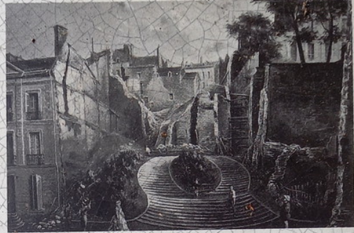
Construction de l'Escalier Denis-Papin vue du pont. E. CERVAIS, collection musée des Beaux-arts du château royal de Blois
