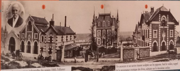
Classique des constructions industrielles des années 1860, l'alliance de la brique et de la pierre influence l'ensemble de l'usine de la Vierge.
